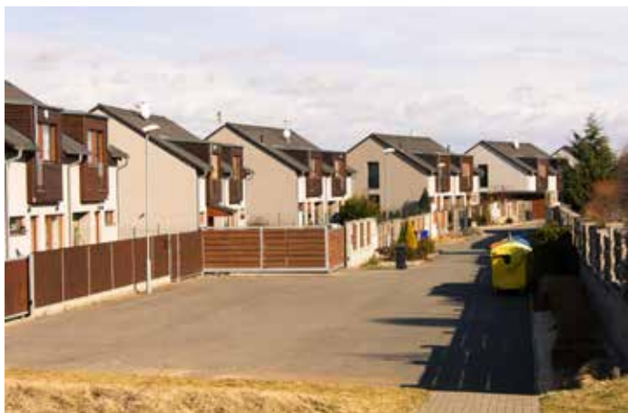
Nová výstavba ve Svémyslicích (únor 2017 / J. Hulík)
