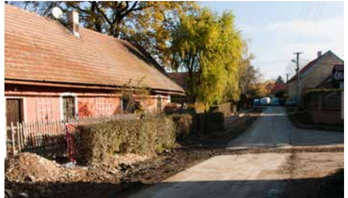
Stavba vodovodu a kanalizace v Dehtárech (listopad 2016 / J. Hulík)
